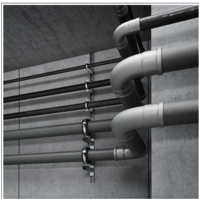
Abb. 4: Beschichtete Stahlrohre (grau) mit Megapress S XL von Viega in der Installation einer Kühlanlage
