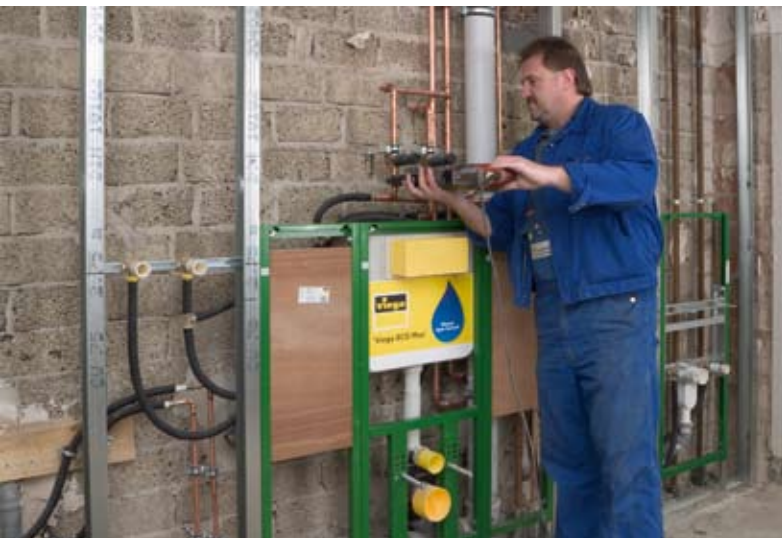
Bild 4: Unterschiedliche Rohrwerkstoffe, hier Sanfix-Fosta (Kunststoff) und Profipress (Kupfer): Alle Verbinder können mit dem gleichen Presswerkzeug verarbeitet werden.
