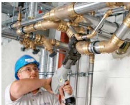
Bild 2: Trinkwasseranlagen aus Edelstahl wie dieses Sanpress-Rohrleitungsnetz lassen sich auch auf engem Raum und mit knappem Radius installieren, da beispielsweise weniger Längenausdehnung berücksichtigt werden muss.
