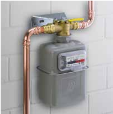
Abb. 6 – 64 Einstützungszähler
