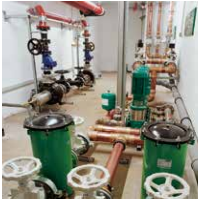
Abb. 7 – 34 Nicht-Trinkwasser-Aufbereitungsanlage
