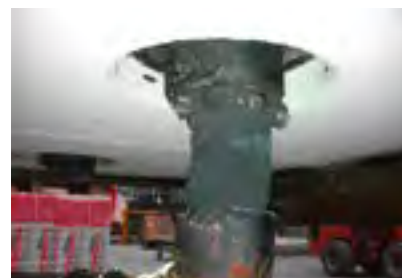
Abb. 238: nach Brandversuch - Gussleitung verschlossen
