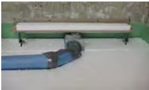
Abb. 273: Die Anschlussleitung zu dämmen kann eine wichtige Maßnahme sein, gerade wenn es um die Einhaltung des erhöhten Schallschutzes geht.
