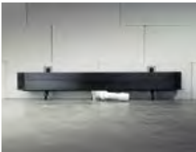
Abb. 270: Neben den schalldämmenden Montagefüßen entkoppelt zusätzlich ein Schallschutzband die Befestigungselemente vom Baukörper.
