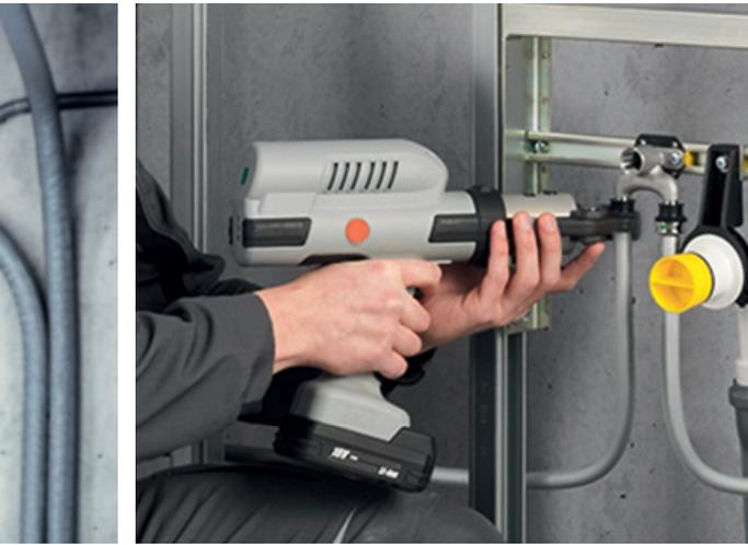
Das flexible Rohr mit einem Inliner aus Edelstahl wird von der Rolle verlegt. Zum Rohrsystem gehören Pressverbinder mit PPSU-Stützkörper als Dichtfläche.
