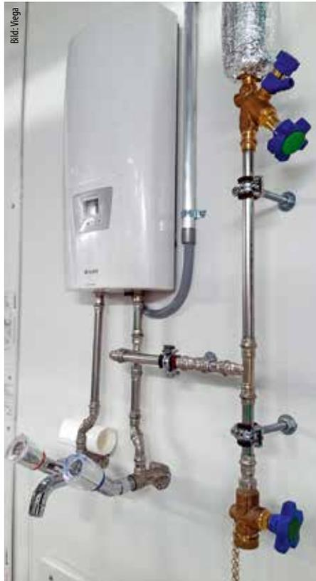
② **Dezentrale Trinkwassererwärmer sind kein genereller Schutz vor hygienekritischer Belastung von Trinkwasser-Anlagen durch Legionellen und entziehen sich auch nicht automatisch der Beprobungspflicht, wenn daraus Wasser an die Öffentlichkeit abgegeben wird.**
