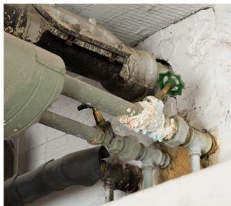
Eine Kontamination des Rohrleitungsnetzes kann bei trinkwasserhygienisch problematischen Betriebsbedingungen prinzipiell überall entstehen, unabhängig von der Leitungslänge. Aber mit größter Wahrscheinlichkeit in Altinstallationen wie dieser.
