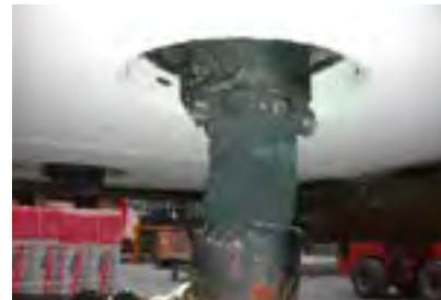
Abb. 231: nach Brandversuch - Gussleitung verschlossen
