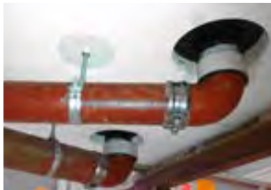
Abb. 230: Guss/HT-Verbinder/Advantix-Brandschutzablauf
