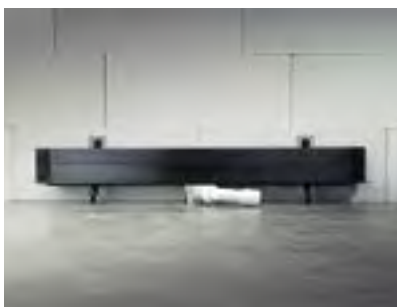
Abb. 263: Neben den schalldämmenden Montagefüßen entkoppelt zusätzlich ein Schallschutzband die Befestigungselemente vom Baukörper.
