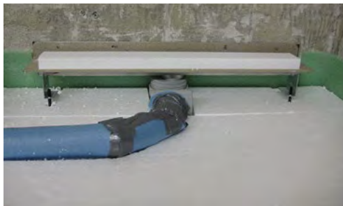
Abb. 274: Die Anschlussleitung zu dämmen kann eine wichtige Maßnahme sein, gerade wenn es um die Einhaltung des erhöhten Schallschutzes geht.
