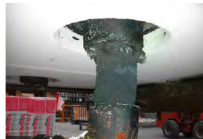
Abb. 239: nach Brandversuch - Gussleitung verschlossen
