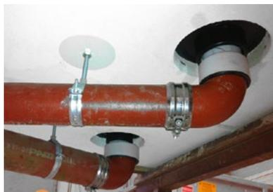
Abb. 238: Guss/HT-Verbinder/Advantix-Brandschutzablauf
