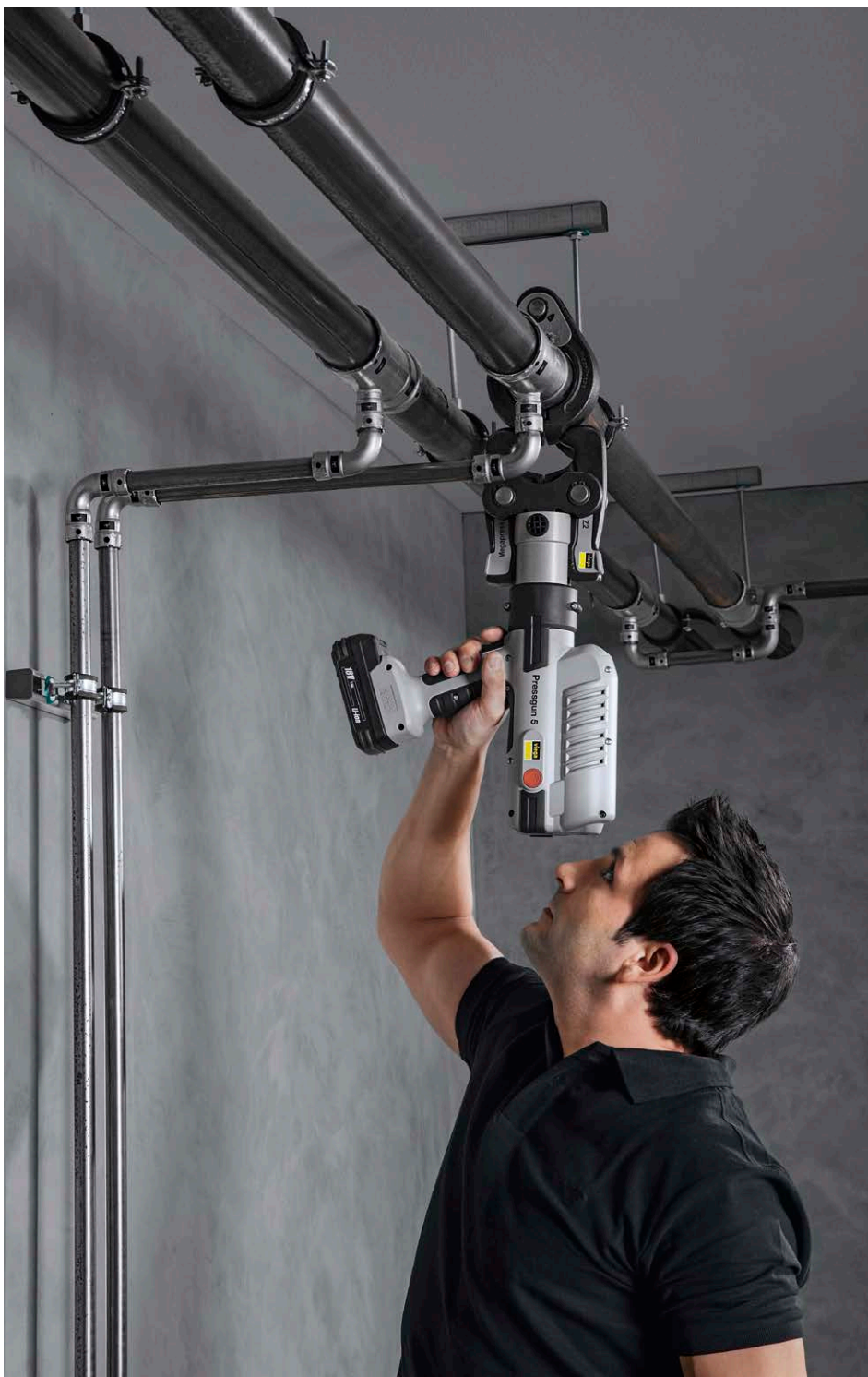
Mit der Pressgun und Viega Megapress einfach und sicher verbinden – ohne zeitintensive Schweißarbeit.
