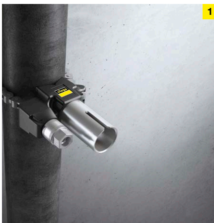
1. Die Bohrvorrichtung zur Führung der Bohrwelle wird am Stahlrohr befestigt.
