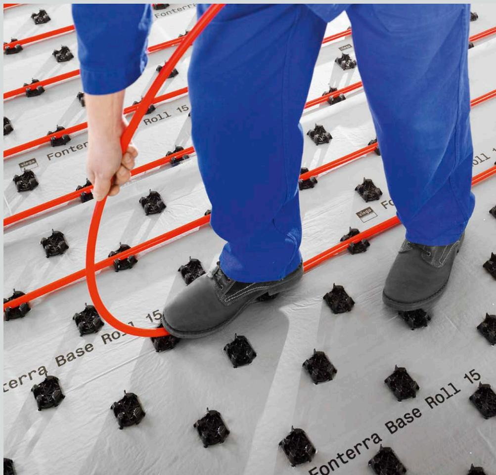
Auch bei dem neuen System Fonterra Base Roll 15 gewährleistet das flexible PB-Rohr 15 x 1,5 mm höchsten Montagekomfort.
