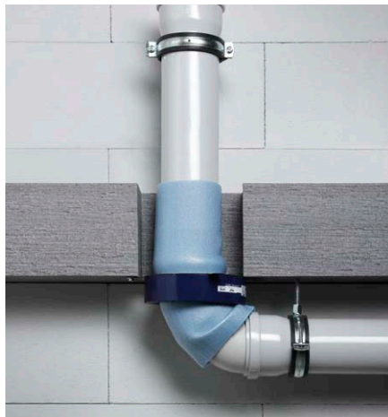
Deckendurchführung mit Brandschutz-Manschette und zwei 45°-Bögen – so geht praxisgerechter Brandschutz.
