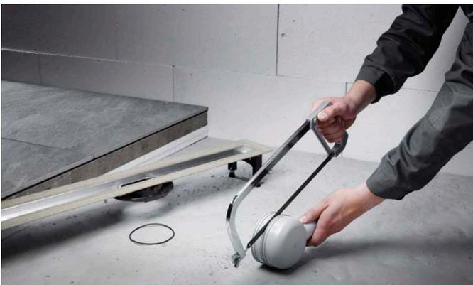
Durch einfaches Absägen lässt sich der Standard-Ablauf noch vor Ort zum Sanierungsmodell umwandeln.
