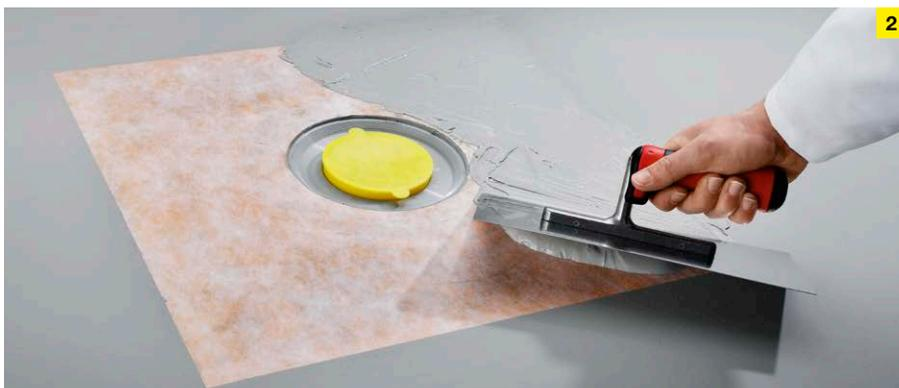
Auftrag der 2. Abdichtungsschicht mit einer in der Baupraxis bewährten Zwei-Komponenten-Kunststoff-Zementmörtel-Kombination.
