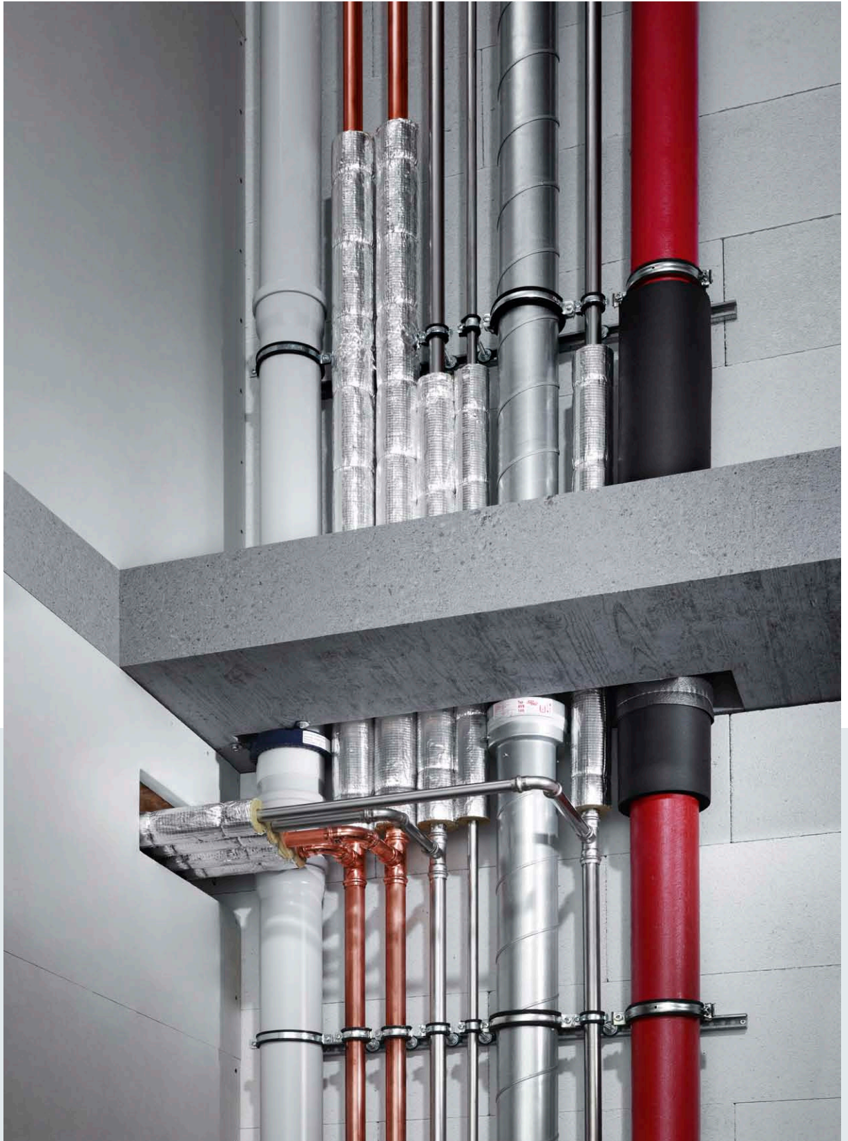
Kalt, warm und sehr wenig Platz. Mit der richtigen Dämmung inklusive Prüfzeugnis von Viega ist das sogar brandschutztechnisch auf Nullabstand machbar.
