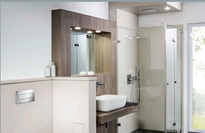
Baderneuerung bei laufendem Hotelbetrieb: Im Hotel Lamm in Ostfildern, Stuttgart, ermöglichten Steptec und Obtego die komfortable Renovierung von zwölf Bädern innerhalb von 14 Tagen.
