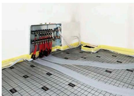
Die Zuleitungen sind in die geschlitzten Dämmschläuche eingebracht. Sie schließen flächenbündig mit der Dämmebene ab.
