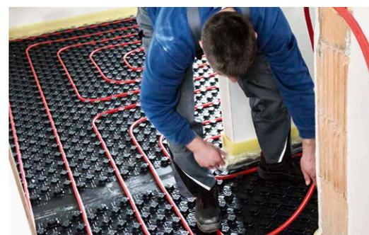
Auf der Dämmebene liegt die Noppenplatte Fonterra Smart zur Aufnahme regelbarer Heizkreise. So freuen sich die Oberloher über eine gleichmäßige Boden- und Raumtemperatur auch in den Transferräumen.
