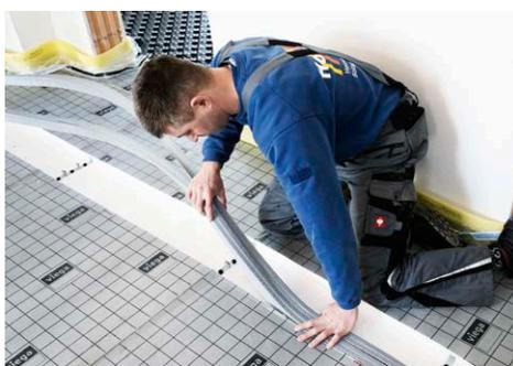
Ein Blick auf die Installationsschritte: Dämmschläuche werden in die Ausschnitte gelegt. Die Bahnen wurden zuvor passgenau an die Heizkreise mit dem Viega Schneidwerkzeug ausgeschnitten.
