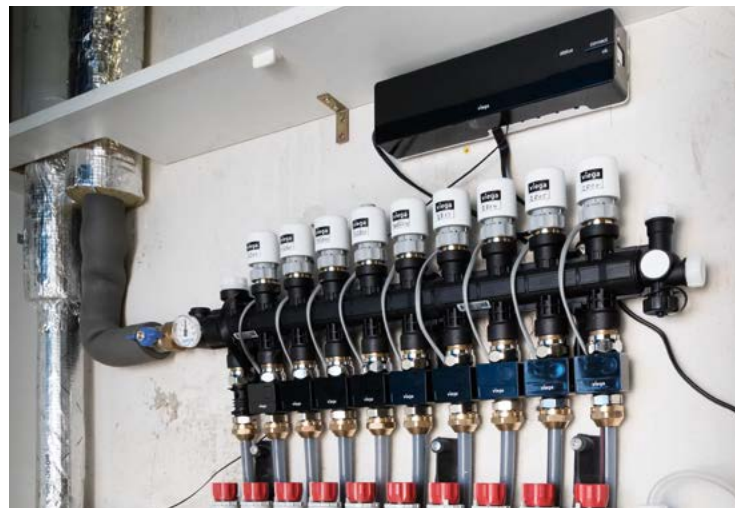
So einfach lässt sich ein automatischer hydraulischer Abgleich installieren: In der Wohnanlage wurden fast 20 solcher Heizkreisverteiler mit Fonterra Smart Control-Aktoren und -Sensoren neu gesetzt. Oben die elektronische Steuereinheit.
