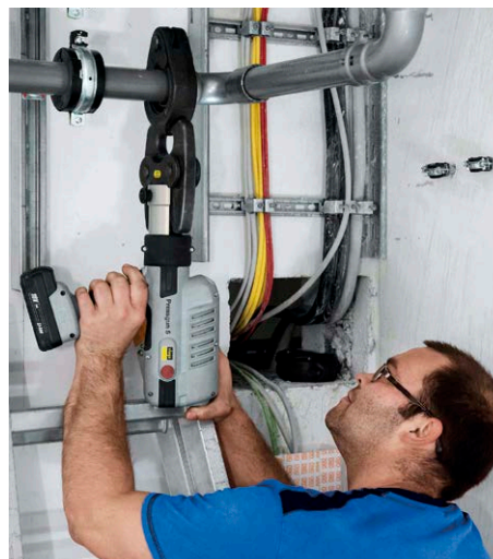
Auf wenig Platz zügig Rohrleitungen mit bis zu 4 Zoll Durchmesser verbinden: kein Problem mit intelligenter Viega Presstechnik.
