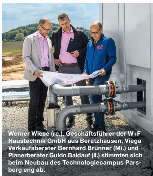
Für die verzinkte Stahlrohr-Installation der Druckluftverteilung kamen ebenfalls Megapress-Verbinder zum Einsatz.
