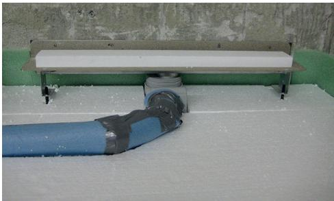
Abb. 283: Die Anschlussleitung zu dämmen kann eine wichtige Maßnahme sein, gerade wenn es um die Einhaltung des erhöhten Schallschutzes geht.
