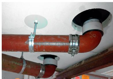
Abb. 247: Guss/HT-Verbinder/Advantix-Brandschutzablauf
