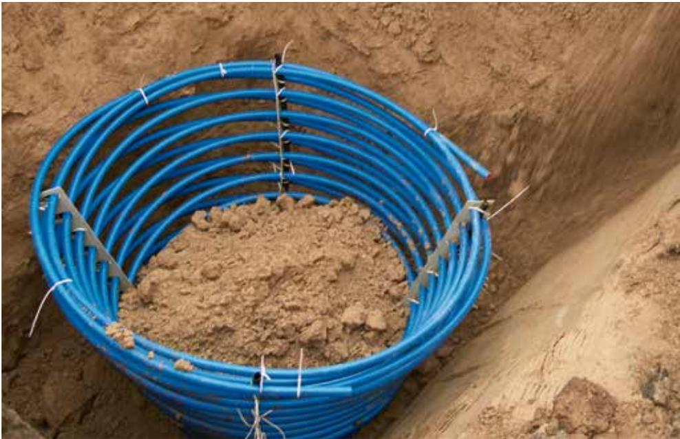
**Erdwärmekörbe fördern die Wärme der oberen Erdschicht.**
