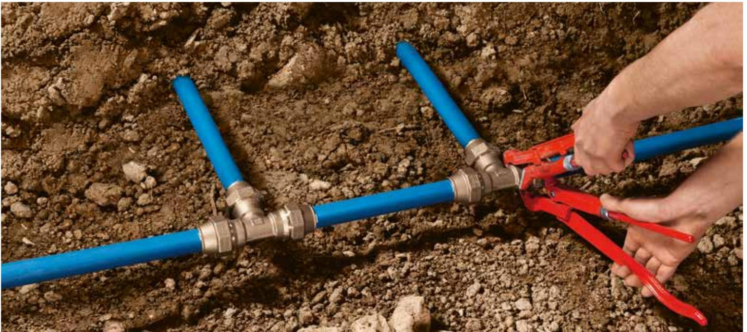
**Viega Maxiplex bietet den entscheidenden wirtschaftlichen Vorteil: Die Klemmverbinder für die Trinkwasserversorgung sind mit wenig Werkzeug schnell montiert.**
