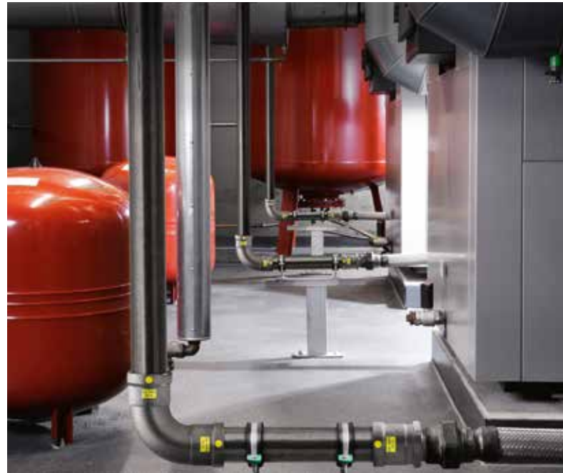
Sicherer Transport für entzündliche Medien – metallene Viega Pressverbinder machen es möglich.
