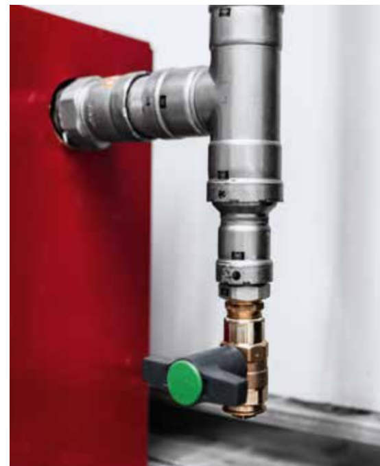
Eine Feuerlöschanlage mit Viega Pressverbindern.
