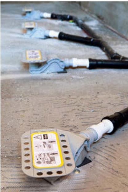
Die hohen Wassereinträge der Wellness-Duschen werden über die mäanderförmige Kombination mehrerer Viega Abläufe abgeleitet.
