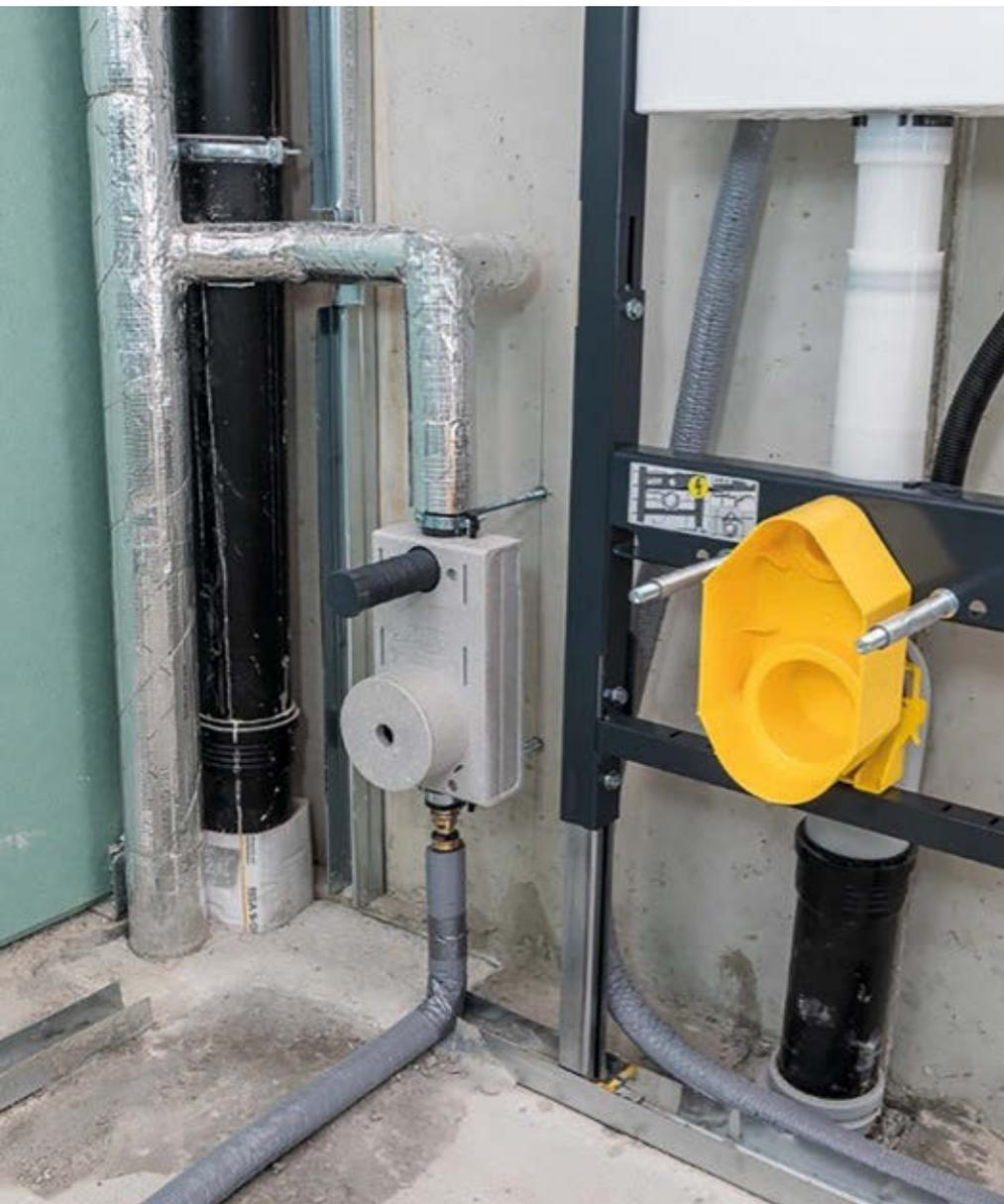
Geht nicht? Gibt's nicht bei dem DIBt-geprüften Rohrleitungssystem Raxofix; hier die abnahmesichere Anbindung der Wasserzählereinheit.
