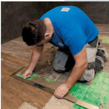
Die millimetergenaue Anpassung des Ablaufs an das Estrichniveau war genauso schnell erledigt wie die Einbindung des Flansches in die Abdichtung im Verbund durch die beigefügte Manschette. Mit dem werksseitig zum Lieferumfang gehörenden Fliesenleger-Set hat Viega die Schnittstelle zwischen Sanitärgeräten und unserer Arbeit perfekt überbrückt.
