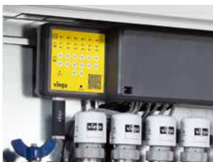
Einfache Übertragung der Inbetriebnahme-Konfiguration per USB-Anschluss
