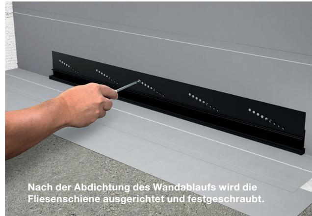
Nach der Abdichtung des Wandablaufs wird die Fliesenschiene ausgerichtet und festgeschraubt.
