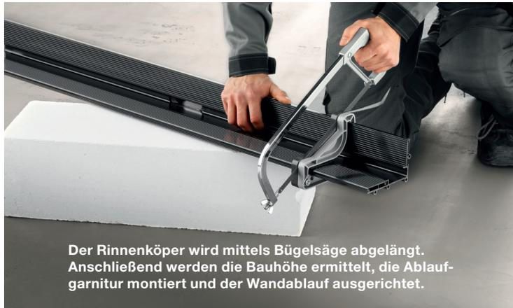
Der Rinnenkörper wird mittels Bügelsäge abgelängt. Anschließend werden die Bauhöhe ermittelt, die Ablaufgarnitur montiert und der Wandablauf ausgerichtet.
