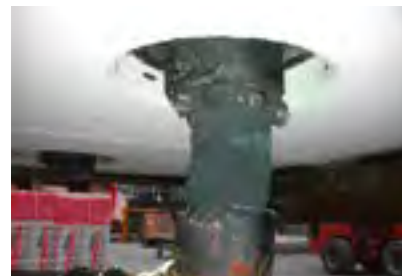
Abb. 244: nach Brandversuch - Gussleitung verschlossen
