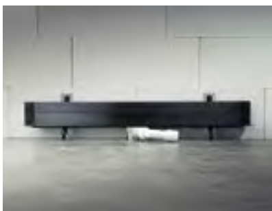
Abb. 276: Neben den schalldämmenden Montagefüßen entkoppelt zusätzlich ein Schallschutzband die Befestigungselemente vom Baukörper.
