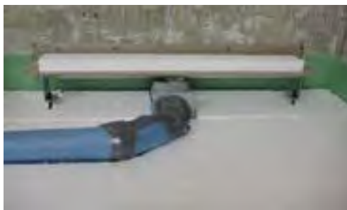
Abb. 279: Die Anschlussleitung zu dämmen kann eine wichtige Maßnahme sein, gerade wenn es um die Einhaltung des erhöhten Schallschutzes geht.
