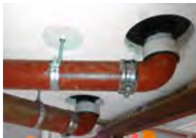
Abb. 243: Guss/HT-Verbinder/Advantix-Brandschutzablauf
