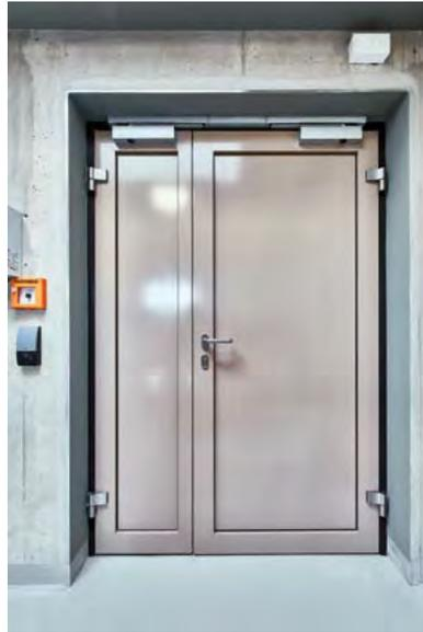
Die Novoferm Rohrrahmentüren mit Paneelfüllung wurden speziell mit Fluchttüröffner und einer bauseitigen Fluchtwegsteuerung ausgestattet. Bild: Novoferm/ Laura Thiesbrummel
