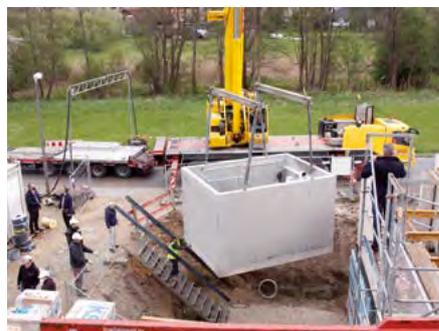
*Vom Lkw ins Erdreich: Nur 20 Minuten dauerte die Einbringung der vorbestückten Heizzentrale für 13 Häuser. Bild: August Brötje GmbH, Rastede*
