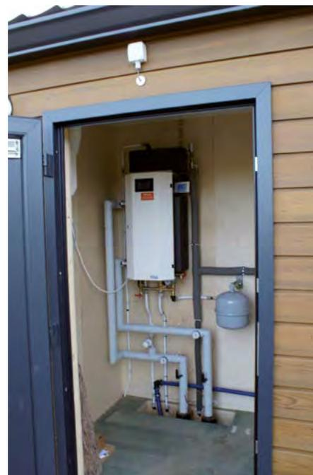
Indirekter Anschluss an die Nahwärmeversorgung der neuen Energiezentrale: platzsparende Wärmeübergabestation Yado|Giro C mit TWE-Anlage in einem neuen „Sunrise Home“
