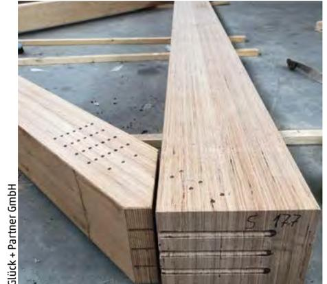
Fertiger Anschluss einer Fachwerk-Diagonalen an einen Trägergurt.
