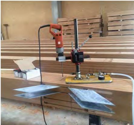
Spezielle Vorrichtungen vereinfachen die Montage und sorgen für passgenaue Anschlüsse. Die Schlitzlöcher wurden nach dem Einlegen der Bleche mit BauBuche-Passstücken geschlossen.
