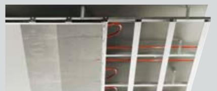
Fonterra Top 12 Deckenheizungssystem. Für den trockenen Innenausbau – auch an Dachschrägen
