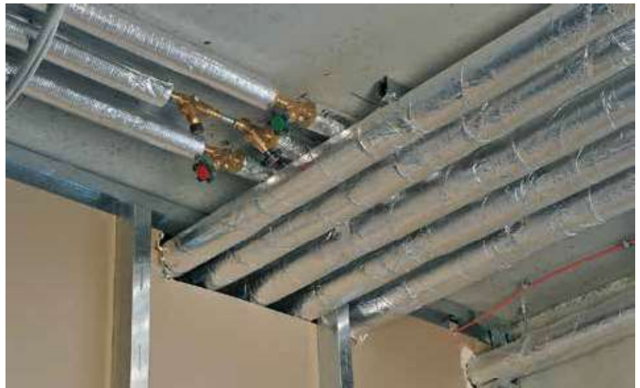
Die Heizungsoptimierung wird gesondert vom Staat gefördert. Die Dämmung von Rohrleitungen für Trinkwasser warm in unbeheizten Räumen sowie der hydraulische Abgleich zählen dazu.
