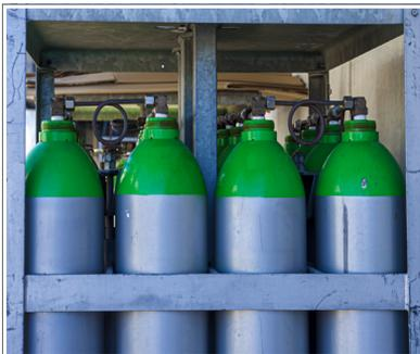
Abb. 147: gesicherte Flüssiggasflaschen
