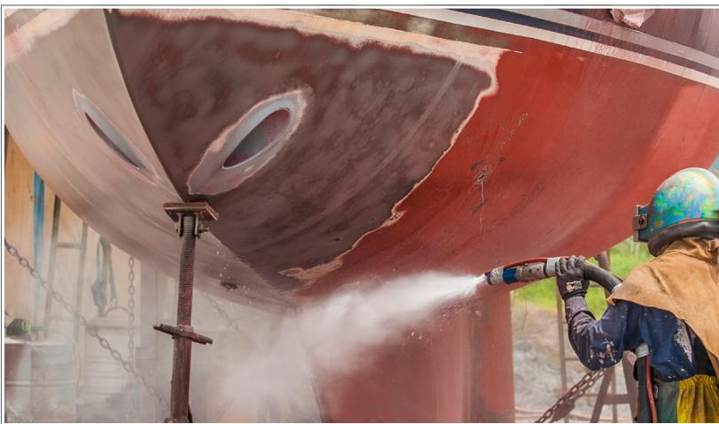
Abb. 119: Aktive Luft beim Sandstrahlen
