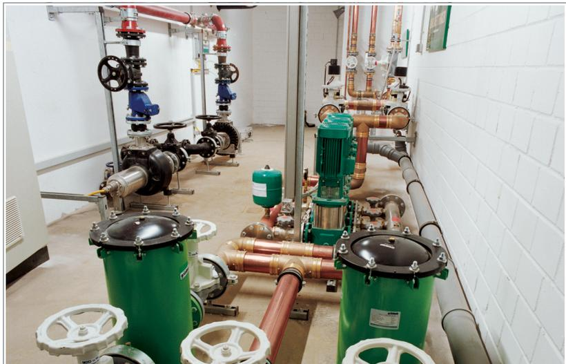
Abb. 100: Viega Rohrleitungssystem Sanpress XL in einer Wasseraufbereitungsanlage
