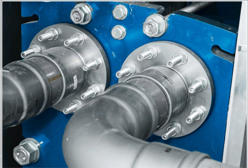
Abb. 103: Sekundäranschluss an einen Wärmetauscher in einer Fernwärme-Übergabestation
