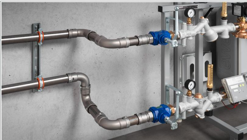
Abb. 104: Fernwärmeübergabestation primärseitig angeschlossen mit Megapress S
