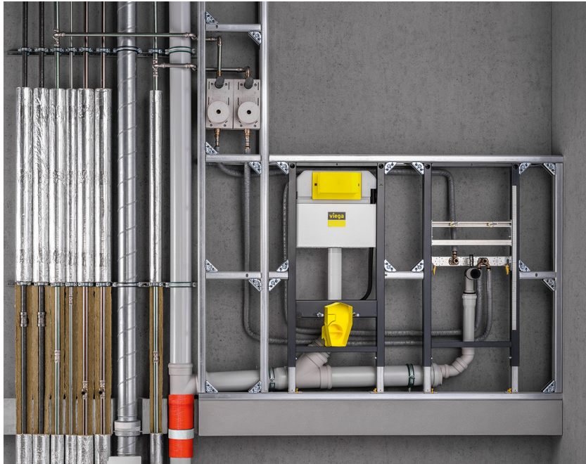
Abb. 133: Brandschutzband Installationsbeispiel
