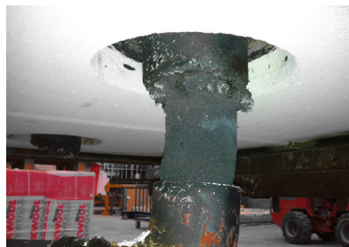
Abb. 248: nach Brandversuch - Gussleitung verschlossen
