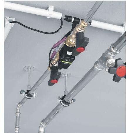
**Bild 4:** Die Sanierung der Trinkwasser-Installation für den normgerechten thermischen Abgleich wurde mit „AquaVip-Zirkulationsreguliertventilen elektronisch (Zirk-E)“ vorgenommen. *Bild: Viega*
