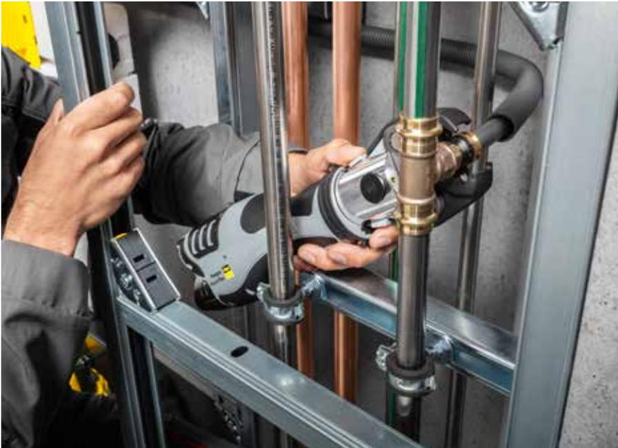
Die Pressgun Picco 6 Plus überzeugt bei wenig Platz und erlaubt stets die einhändige Verpressung.
