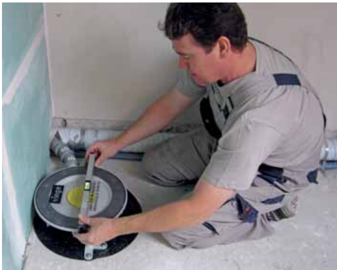
In der Sanierung werden idealerweise Bodenabläufe gesetzt, die sich bei hoher Ablaufleistung und Sicherheit möglichst einfach an die spätere Bodenhöhe anpassen lassen.
