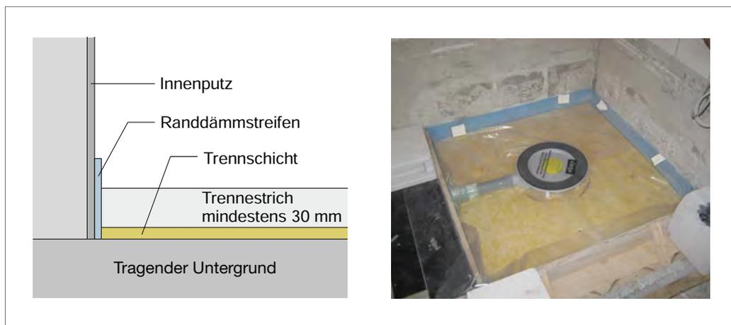
Abb. 249: Der Randdämmstreifen muss lückenlos und vollständig, auch hinter dem Bodenablauf durchgeführt werden und dabei großzügig über der Estrich Oberkante überstehen.
