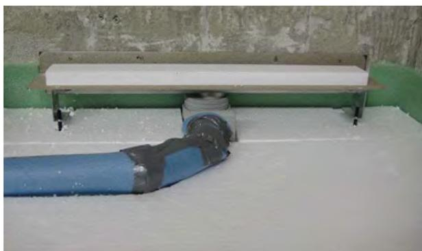
Abb. 243: Die Anschlussleitung zu dämmen kann eine wichtige Maßnahme sein, gerade wenn es um die Einhaltung des erhöhten Schallschutzes geht.
