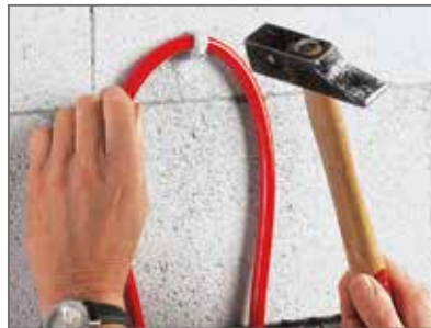
Abb. 188: Fixierung im Bogenbereich
