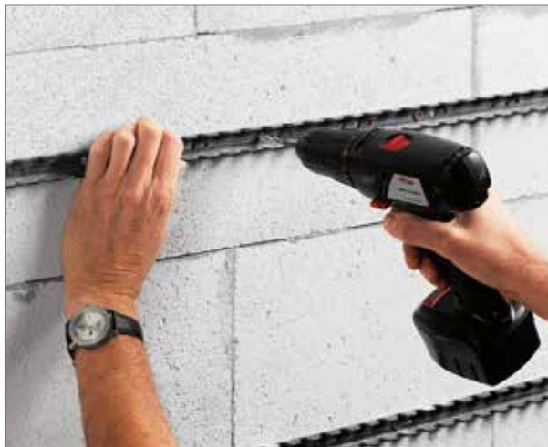
Abb. 186: Befestigung der Klemmschienen
