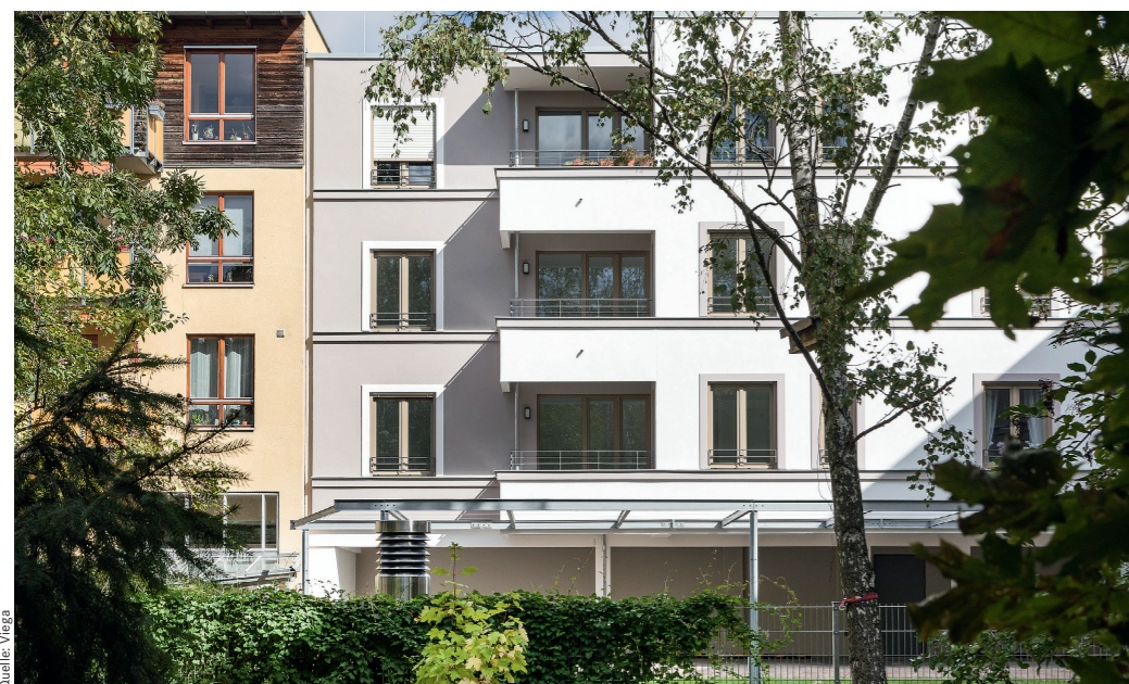
Für einen klimaneutralen Gebäudesektor bis 2050 muss der Einsatz von Wärmepumpen auch im Geschosswohnungsbau forciert werden. Die hohen Systemtemperaturen von Trinkwasser warm stehen dem bislang im Weg.
