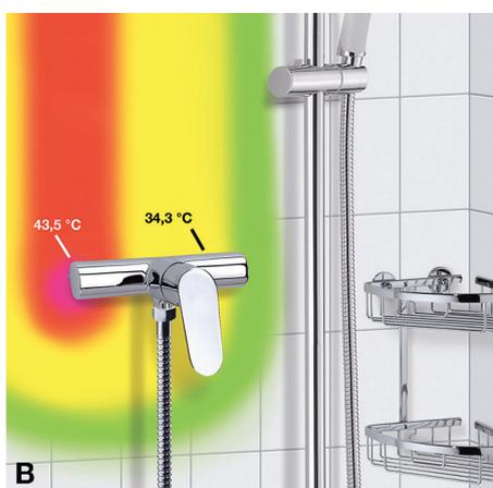
Bild 1: Früher: Etagenzapfstelle für vier Mietparteien (A); Wien, IV Bezirk [1]; heute: Fremderwärmung von Trinkwasser kalt durch einen PWH-Anschluss, der in die Zirkulation einbezogen wurde (B).
